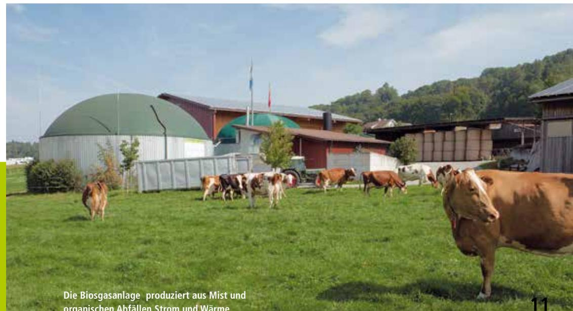
Die Biogasanlage produziert aus Mist und organischen Abfällen Strom und Wärme.
